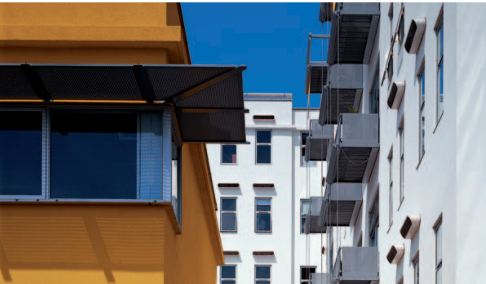
Piper Building, Inglaterra. Sistema de aislamiento exterior de fachadas StoTherm Classic.
