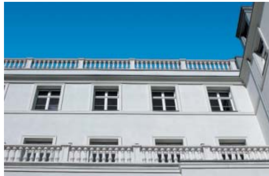
Mendelsohn Palais, Berlin Architekturbüro: Sadowski & Lebiada, Architekten Stuhlemmer Architekten
