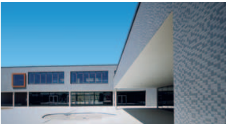
Escuela primaria de Erding, D-Erding Estudio de arquitectura: Architekten Dinkel, Persch / Stefan Dinkel, D-Munich StoVentec con cerámica
